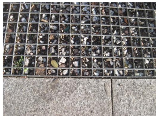
Rys. 1.27. Wzmocnienie nawierzchni gruntowej siatkami stalowymi
