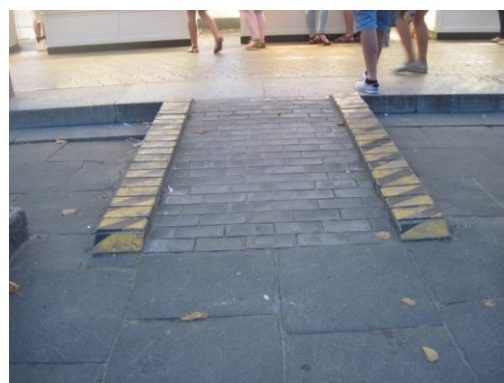
Rys. 1.13. Pochylnia z ogranicznikami bocznymi z jednej i z dwóch stron
