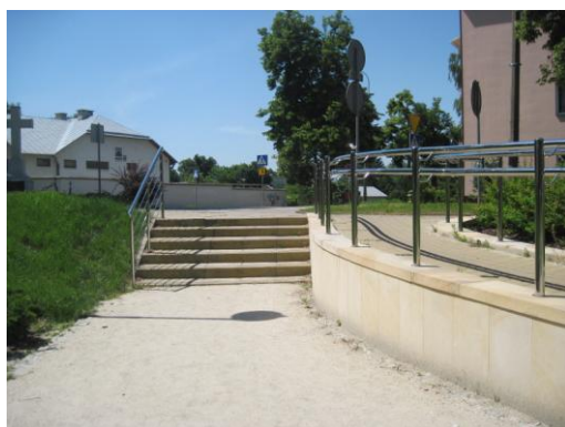
Rys. 1.14. Pochylnia z obustronnymi poręczami oraz schody z jednostronnymi
