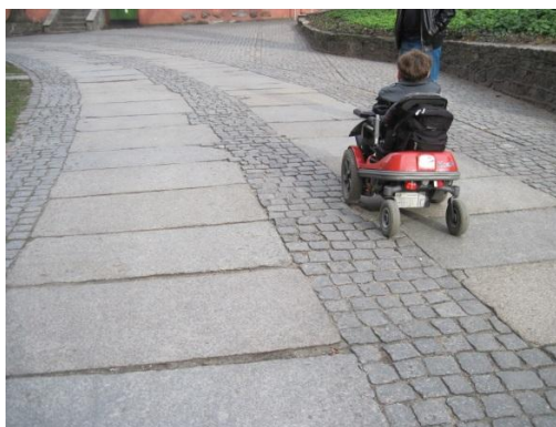
Rys. 1.8 Podział strefy zasadniczej chodnika na dwie podstrefy
