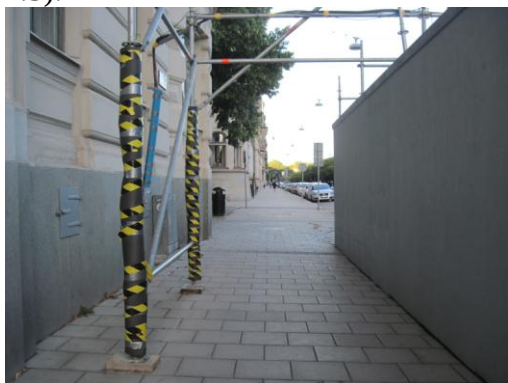
Rys. 4.5. Zasygnalizowanie wejścia między wyгородzenia gładkie lub nieregularne (rusztowania jedno- i dwustronne)
