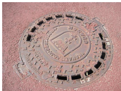
Rys. 1.34. Najlepiej, gdy pokrywy są bez otworów bądź z niewielkimi otworami
