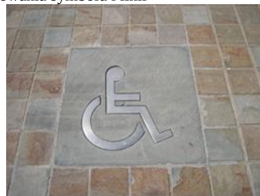
Rys. 5.7. Przykłady reliefów symboli z tworzywa i metalu
