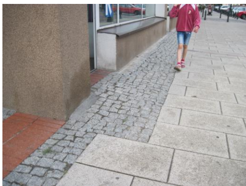
Rys. 1.23. Podstrefa przybudynkowa o nawierzchni nierównej - z kostki kamiennej nieregularnej
