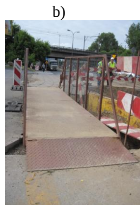
Rys. 4.6. Kładki z balustradami; a) z listwami bocznymi na krawędzi, b) bez listew
