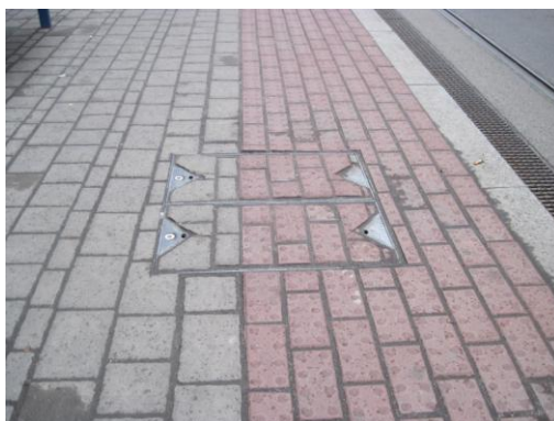
Rys. 3.9. Kontynuacja nawierzchni pasa ostrzegawczego na pokrywie studzienek
