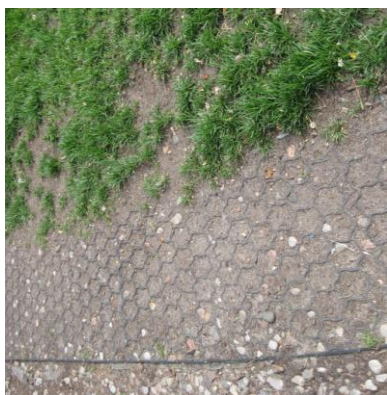
Rys. 1.26. Wzmocnienie nawierzchni gruntowej siatkami z mas plastycznych
