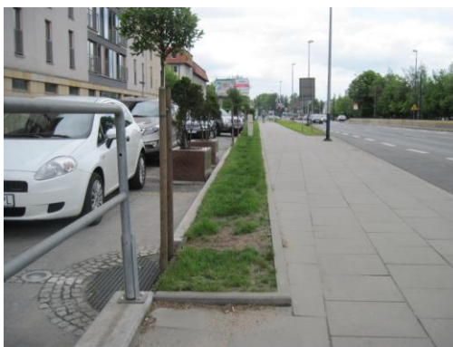
Rys. 1.9 Wyгородzenie chodnika i odsunięcie pieszego od krawędzi skarpy za pomocą trawnika
