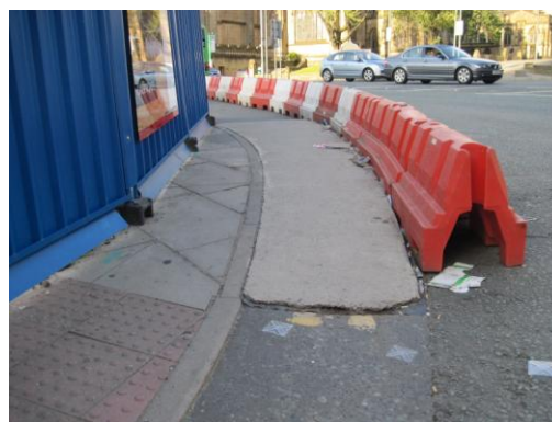
Rys. 4.9. Obejście na jezdni w łuku
