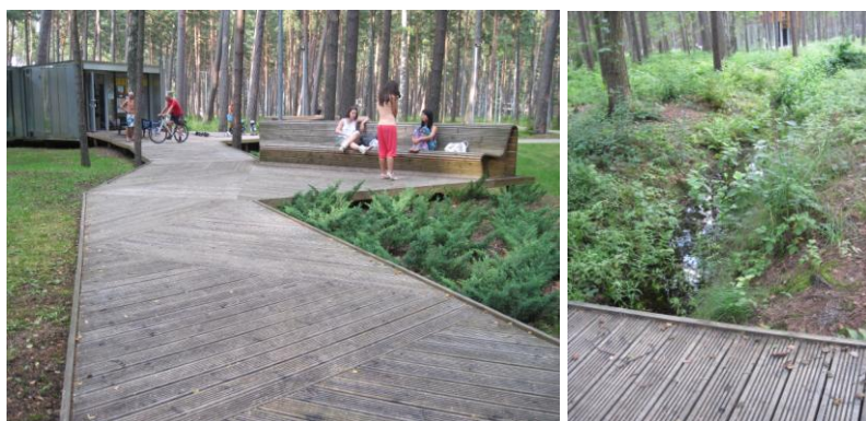
Rys.6.8. Chodnik na terenie parku, z utwardzoną nawierzchnią wyniesioną powyżej terenu
