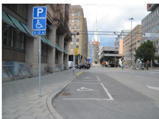
Rys. 5.19. Korytarz dostępu, jako prostopadły separator dwóch kopert, wymusza miejscowe podniesienie niwelety jezdni do poziomu chodnika (bez oznakowania poziomego obszaru wyłączenia z ruchu zakazującego parkowania)
