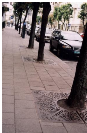
Rys. 1.25. Nawierzchnia ażurowa stosowana wokół drzew
