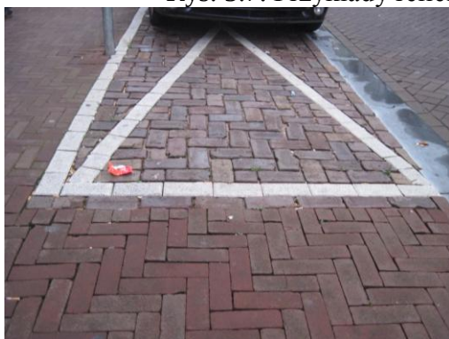
Rys. 5.8. Nawierzchnie zastępujące malowanie zasadnicze
