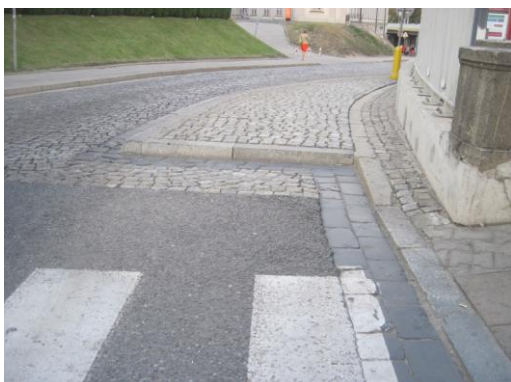
Rys. 2.10. Azyle wyniesione zapobiegają wjeżdżaniu pojazdów i potrącaniu pieszych
