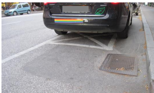
Rys. 5.18. Korytarz dostępu, jako prostopadły separator dwóch kopert, wymusza miejscowe podniesienie jezdni poprzez dolewkę asfaltu (z oznakowaniem poziomym obszaru wyłączenia z ruchu zakazującym parkowania)
