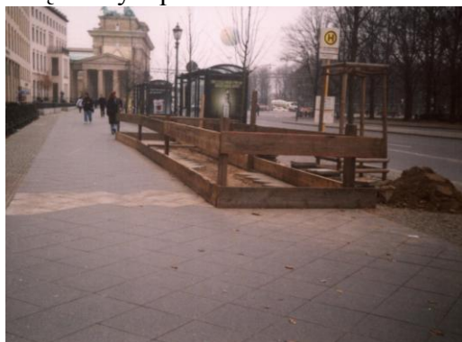
Rys. 4.3. Wygradzenia gładkie bez wystających elementów
