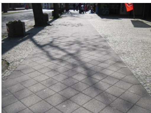
Rys. 1.20. Strefa zasadnicza powinna mieć nawierzchnię gładką i równą
