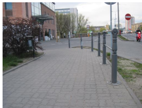
Rys. 2.7. Wygrodzenie „uniemożliwia” przekraczanie jezdni w niepożądanym miejscu
