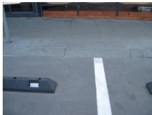
Rys. 5.21. Odstęp pomiędzy krawędziami ograniczników parkingowych pozwala przejechać wózkom inwalidzkim
