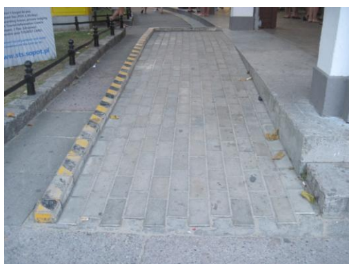
Rys. 1.13. Pochylnia z ogranicznikami bocznymi z jednej i z dwóch stron
