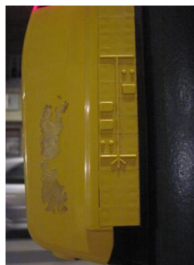
Rys. 2.9. Przykładowe charakterystyki przejść dla pieszych umieszczone na kasetach sterowniczych z przyciskiem zgłoszeniowym sygnalizacji świetlnej
