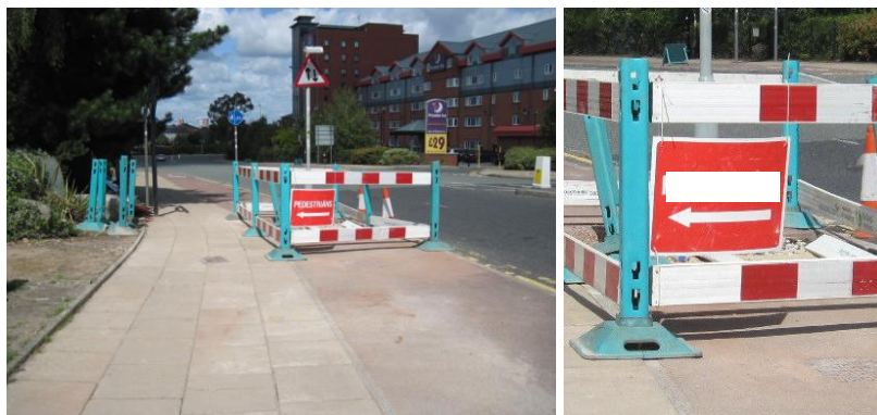
Rys.4.11. Podanie uściślającego kierunku poruszania się pieszych
