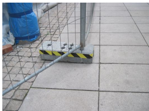
Rys. 4.4. Wyróżnione betonowe podstawy wygradzeń "wchodzących" w szerokość chodnika
