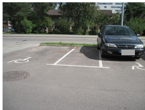
Rys. 5.2. Idea wspólnego korytarza dostępu oraz proponowane oznakowanie poziome
