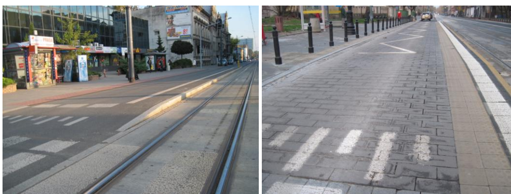
Rys. 3.14. Dwie nawierzchnie (asfaltowa i betonowa) na peronie wspólnym z pasem ruchu
