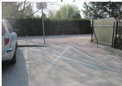
Rys. 5.11. Koperty z obniżonym chodnikiem lub podniesioną nawierzchnią
