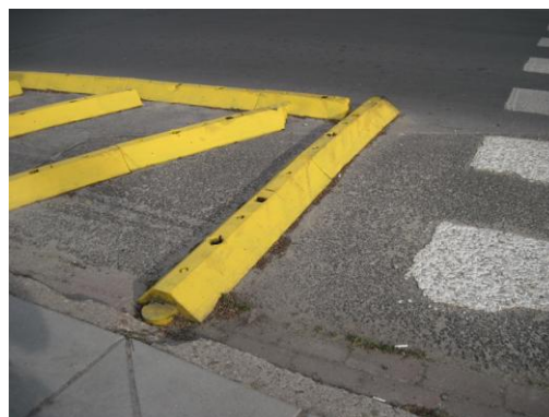
Rys. 2.11. Kolor żółty separatora oraz wyniesienie ułatwia poruszanie się osoby niewidomej i niedowidzącej oraz zabezpiecza ją przed potrąceniem przez pojazd
