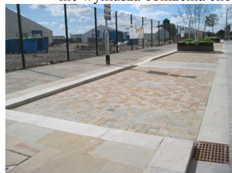
Rys. 5.17. Korytarz dostępu, jako prostopadły do dwóch kopert separator, wymuszając miejscowe obniżenie chodnika
