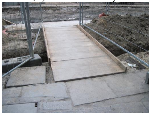
Rys. 4.7. Kładka dla pieszych z ogranicznikami bocznymi na krawędzi w postaci listew bez balustrad
