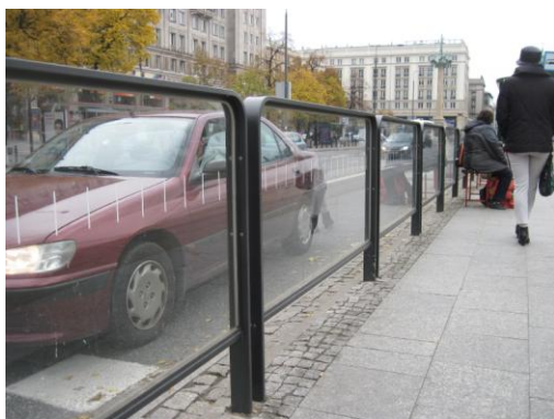
Rys. 3.15. Wygradzenie ażurowe peronu przystanku
