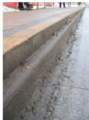
Rys. 3.7. Krawężniki z zaokrągloną powierzchnią i przesuniętą krawędzią boczną zabezpieczają przed przemieszczeniami, powodują zsuwanie się kół i nieprzecinanie opon
