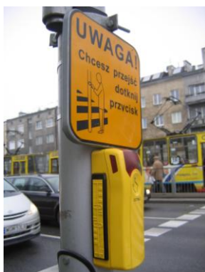
Rys. 2.15. Kasety koloru żółtego z planem topograficznym/mapą plastyczną przejścia umieszczoną na wprost przejścia i dwoma przyciskami
