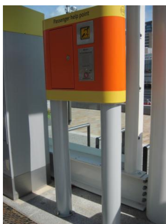
Rys. 3.19. Panel z informacją głosową wraz z opcją dla niedosłyszących (pętlą indukcyjną)
