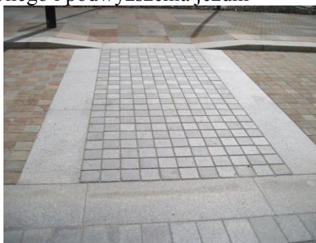
Rys. 5.17. Korytarz dostępu, jako prostopadły do dwóch kopert separator, wymuszając miejscowe obniżenie chodnika
