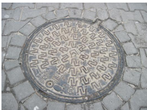
Rys. 1.34. Najlepiej, gdy pokrywy są bez otworów bądź z niewielkimi otworami
