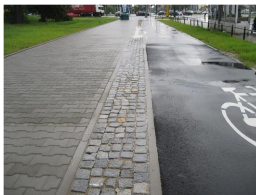
Rys. 1.1. Należy unikać łączenia drogi dla rowerów z chodnikiem
