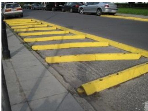
Rys. 2.11. Kolor żółty separatora oraz wyniesienie ułatwia poruszanie się osoby niewidomej i niedowidzącej oraz zabezpiecza ją przed potrąceniem przez pojazd
