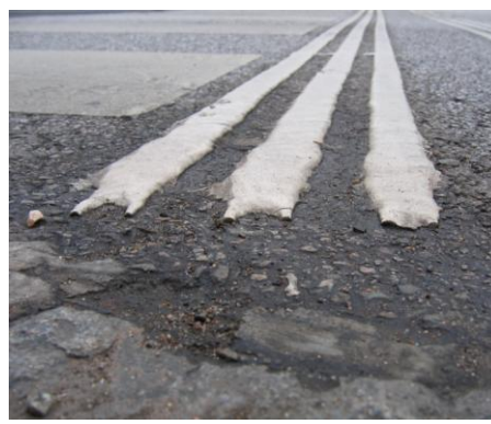
Rys. 2.12. Nawierzchnia pasów prowadzących na jezdni; a) nawierzchnia brukowana na torowisku tramwajowym, b) i c) nawierzchnia nakrapiana z masy chemoutwardzalnej
