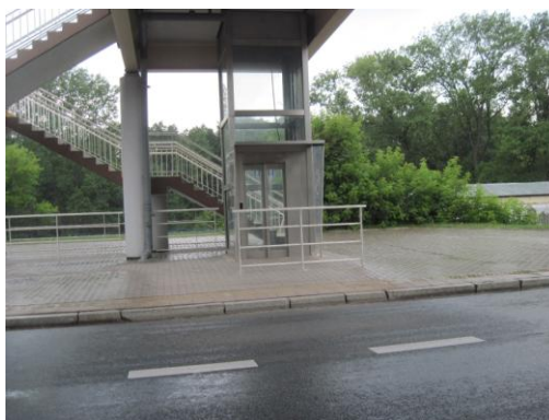
Rys. 2.17. Wygrodzenie pomiędzy dźwigiem a jezdnią zapobiega zjazdowi na jezdnię.
