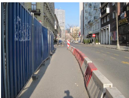
Rys. 4.8. Obejście na jezdni w linii prostej
