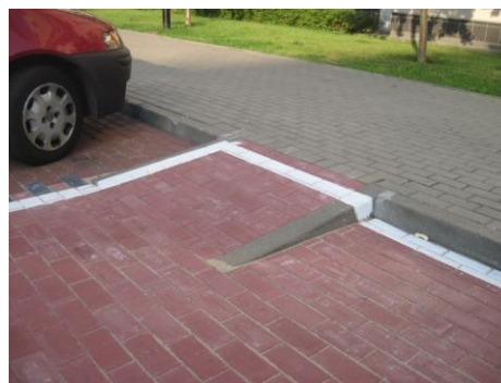
Rys. 5.13. Podwyższenie odcinka nawierzchni koperty do wysokości chodnika
