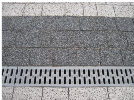
Rys. 1.37. Nawierzchnia przekrycia odwodnienia i chodnika powinny być na jednakowym poziomie a zagłębienie odwodnienia bez przykrycia
