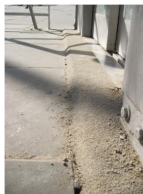
Rys. 2.18. Niewielkie podniesienie chodnika i progu zabezpiecza urządzenia dźwigowe przed zalaniem wodą
