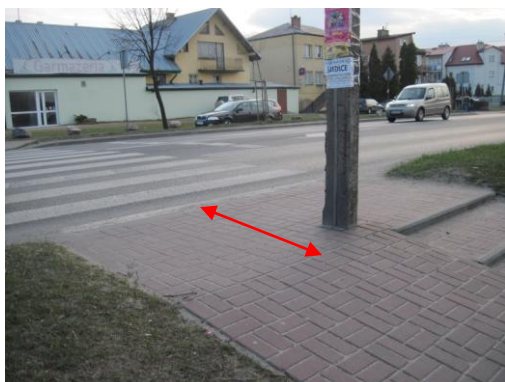
Rys. 2.1. Chodnik przylegający do jezdni (spełnia wymagania minimalnej szerokości 1,5 m i spadku \approx 1\% )
