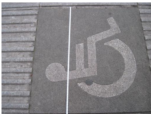
Rys. 3.12. Gładka płyta środkowa z reliefem
