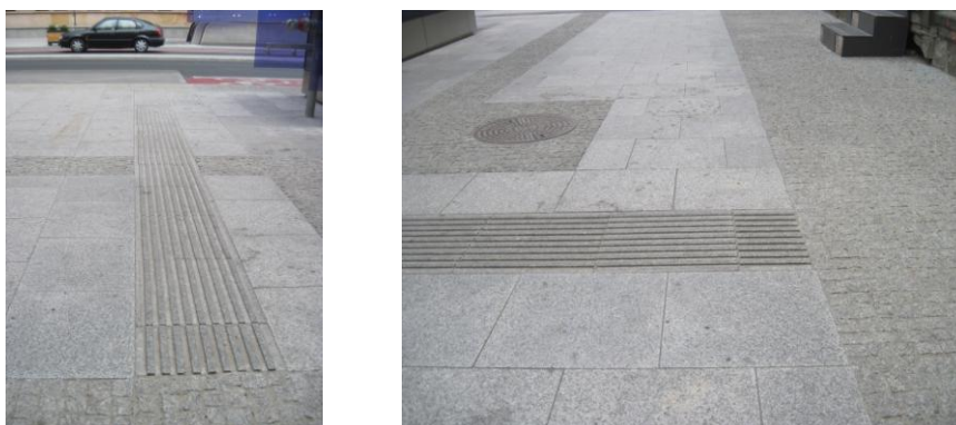
Rys. 3.6. Pas prowadzący ułożony prostopadle do chodnika od miejsca oczekiwania na przystanku do nawierzchni pozostałej - podstrefy przybudynkowej
