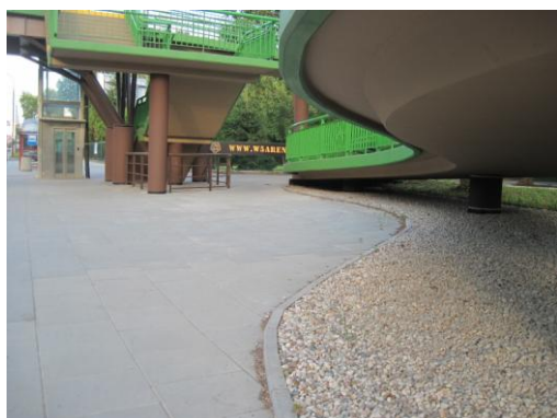
Rys. 2.21. Przykłady zabezpieczenia poprzez wyгородzenia lub obrzeża chodnikowe niskiej przestrzeni pod obiektem
