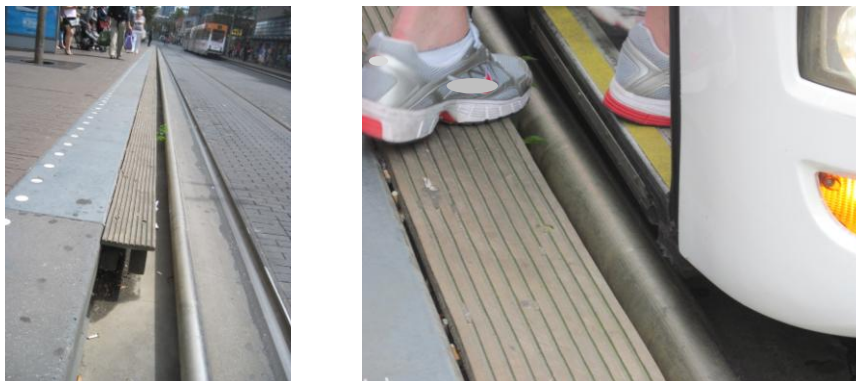
Rys. 3.10. Wydłużenie krawędzi peronu w wyniku zastosowania odbojnic rurowych
