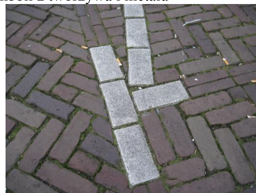
Rys. 5.8. Nawierzchnie zastępujące malowanie zasadnicze
