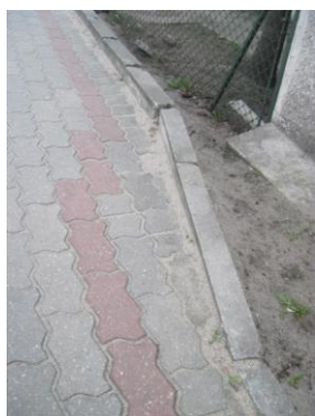
Rys. 2.6. Podwyższona wysokość krawężnika ułatwia niewidomemu wychwycenie go laską
