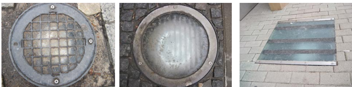
Rys. 1.40. Punkty świetlne o nawierzchni antypoślizgowej
