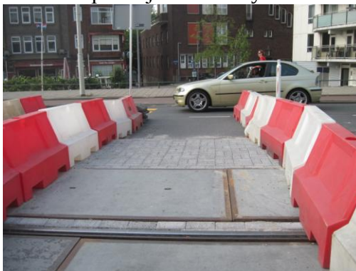
Rys. 4.10. Przejście czasowe dla pieszych przez jezdnię, wygrodzone zaporami U-25c
