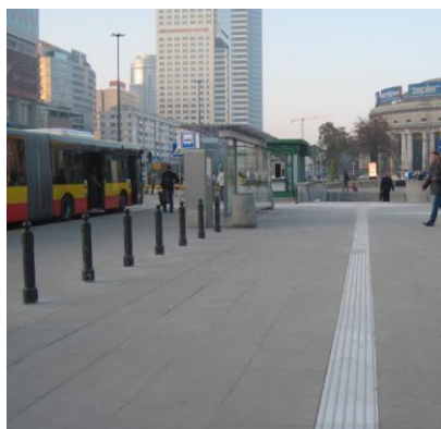
Rys. 1.29. Przebieg prostoliniowego pasa prowadzącego
