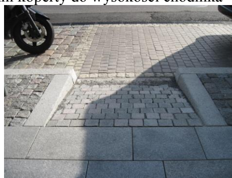
Rys. 5.15. Pochylnia wkomponowana w strefie dodatkowej przyulicznej chodnika
