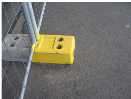
Rys. 4.4. Wyróżnione betonowe podstawy wygradzeń "wchodzących" w szerokość chodnika
