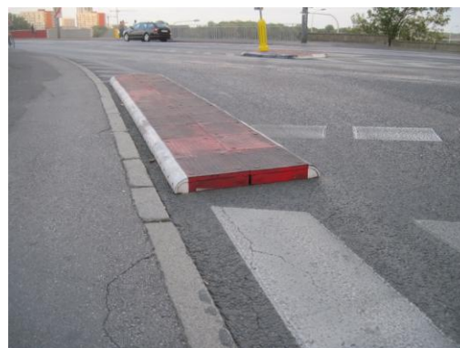
Rys. 2.10. Azyle wyniesione zapobiegają wjeżdżaniu pojazdów i potrącaniu pieszych
