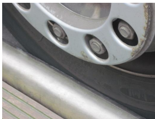
Rys. 3.8. Rury zabezpieczają przed uderzeniami kół o krawężniki i przecinaniem opon
