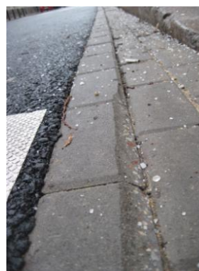
Rys. 5.20. Ścięte ostre krawędzie korytek ściekowych.
