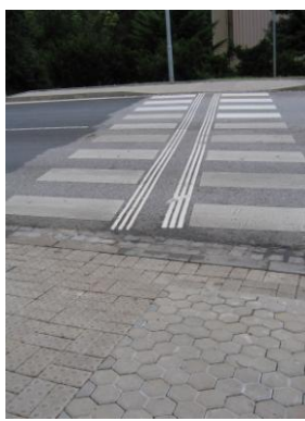
Rys. 2.12. Nawierzchnia pasów prowadzących na jezdni; a) nawierzchnia brukowana na torowisku tramwajowym, b) i c) nawierzchnia nakrapiana z masy chemoutwardzalnej
