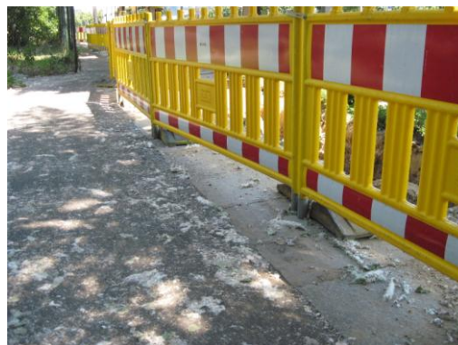
Rys. 4.3. Wygradzenia gładkie bez wystających elementów
