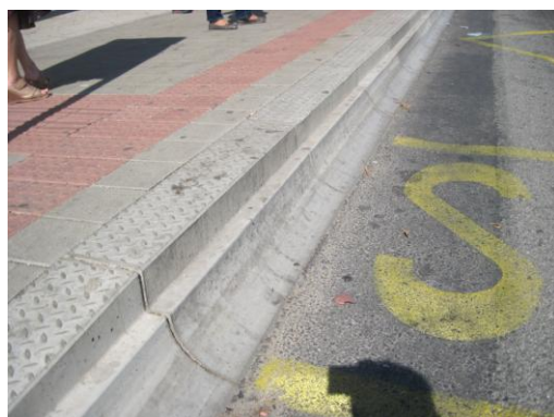
Rys. 3.7. Krawężniki z zaokrągloną powierzchnią i przesuniętą krawędzią boczną zabezpieczają przed przemieszczeniami, powodują zsuwanie się kół i nieprzecinanie opon
