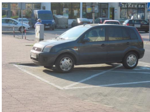
Rys. 5.11. Koperty z obniżonym chodnikiem lub podniesioną nawierzchnią
