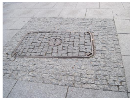
Rys. 1.35. Antypoślizgowe nawierzchnie pokryw
