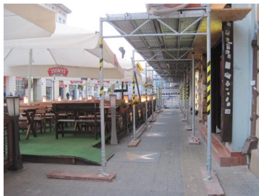
Rys. 4.5. Zasygnalizowanie wejścia między wyгородzenia gładkie lub nieregularne (rusztowania jedno- i dwustronne)
