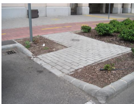
Rys. 5.16. Korytarz dostępu, jako boczna odnoga chodnika głównego nie wymusza obniżenia chodnika głównego i podwyższenia jezdni
