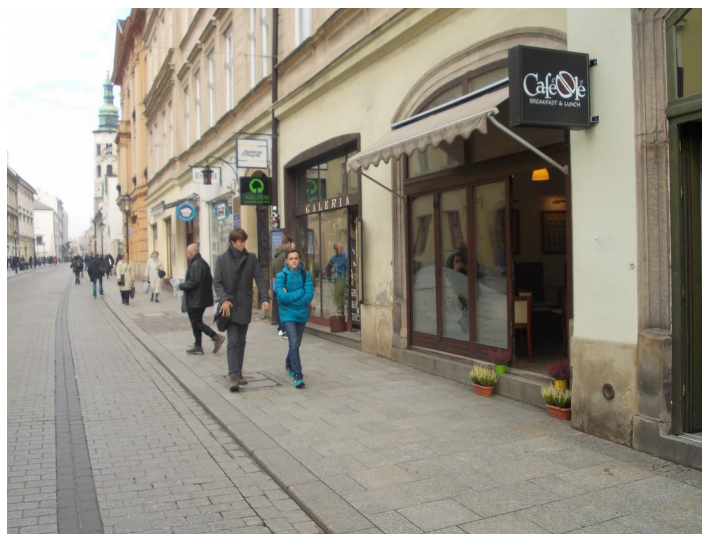
Fot. 7. Kraków, Stare Miasto. Nawierzchnia chodnika wykonana wyłącznie z szerokich kamiennych płyt.
