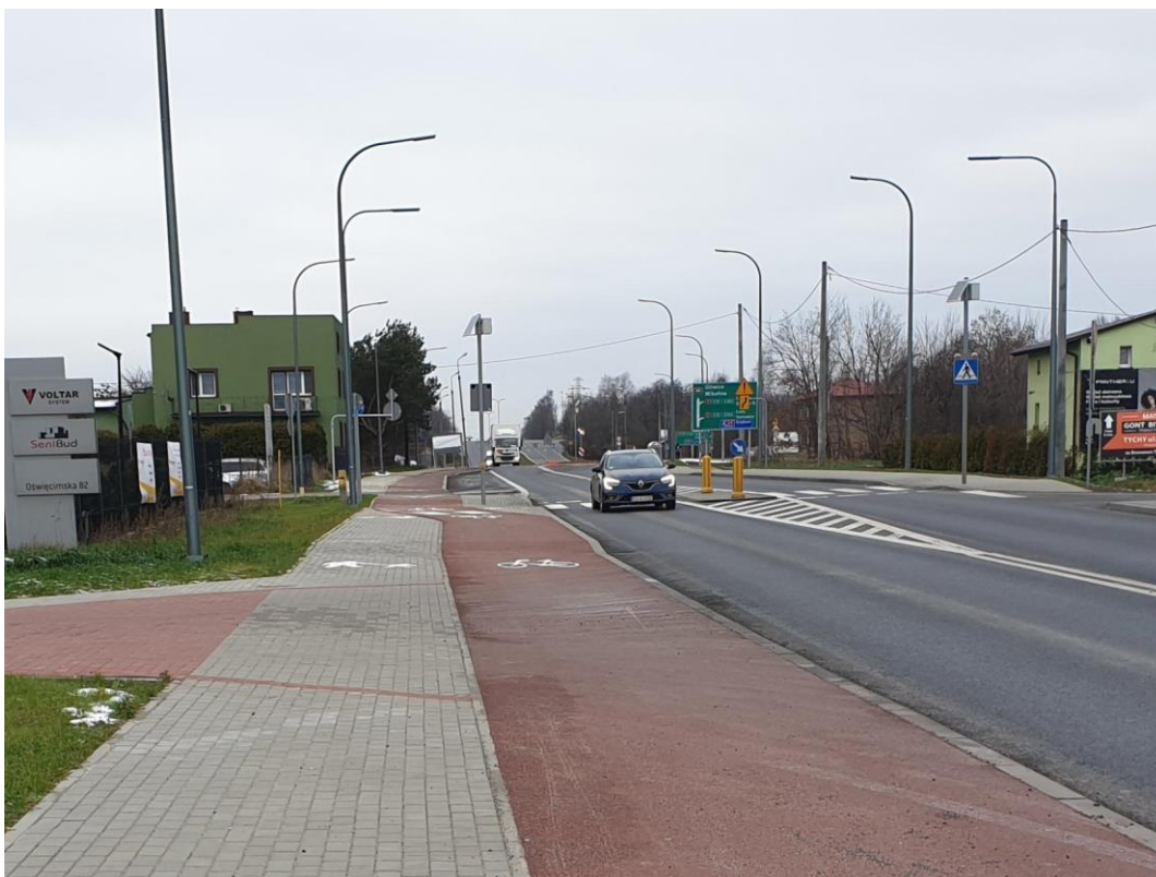
Rys. Ciągłość nawierzchni chodnika i DR w obrębie zjazdu. Tychy, ul. Oświęcimska (fot. UM Tychy)
