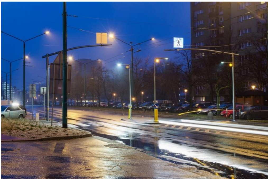
Rys. Wertykalne oświetlenie przejścia dla pieszych. Tychy, ul. (fot. UM Tychy)
