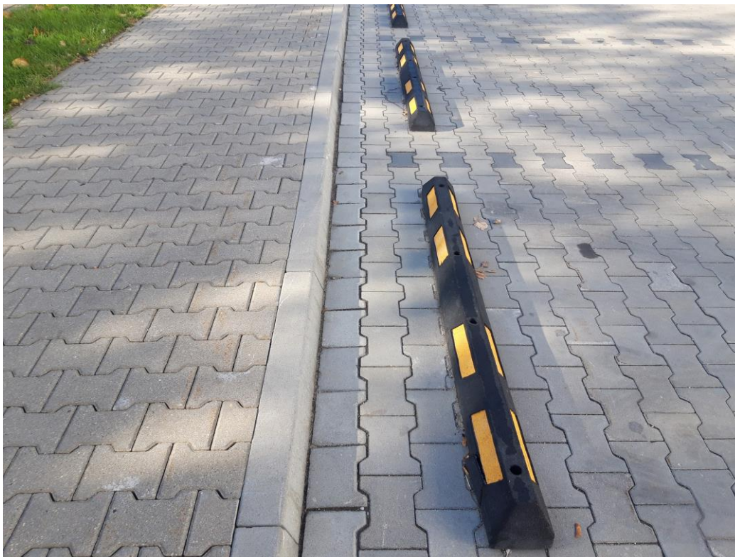
Rys. Separatory prefabrykowane chroniące przed najechaniem na chodnik. Warszawa (fot. Grzegorz Wójkowski)
